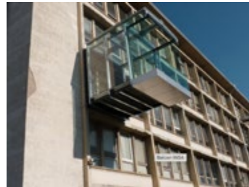
Un prototype d'extension de façade à l'Insa Strasbourg, 2016 Porte à faux de 4m.
